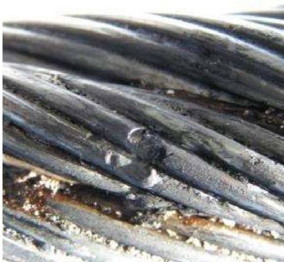
Slika 2.4: Poškodbe zaradi električnega toka
