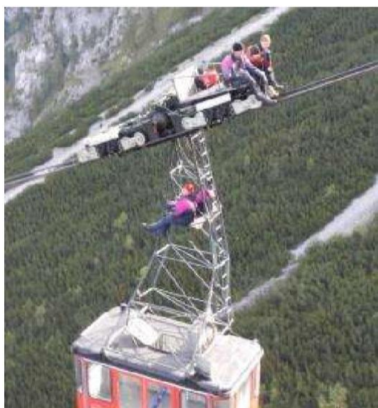
Slika 3.10: Vizualni pregled nosilne vrvi s pripravo za sedenje in ležanje
