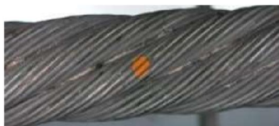
Slika 4.24: Korozija 1,5 x premer pramena
