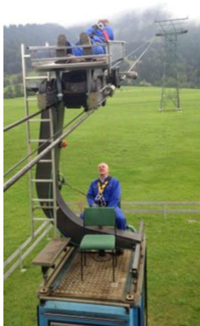
Slika 5.28: Vizualni pregled nosilne vrvi Grüntenseilbahn
