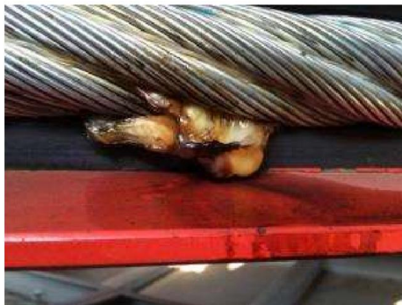
Slika 2.7: Poškodbe zaradi električnega toka
