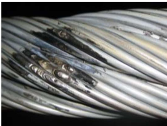
Slika 2.10: Poškodbe na vrvi zaradi strele
