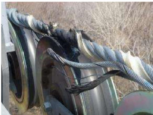
Slika 2.6: Poškodbe zaradi električnega toka
