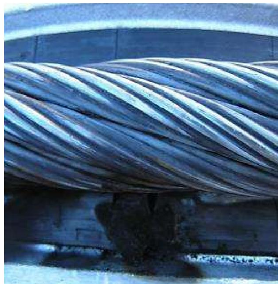
Slika 2.4: Poškodbe zaradi električnega toka
