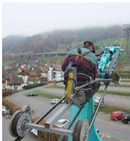
Slika 3.9: Vizualni pregled nosilnih vrvi s pripravo za sedenje
