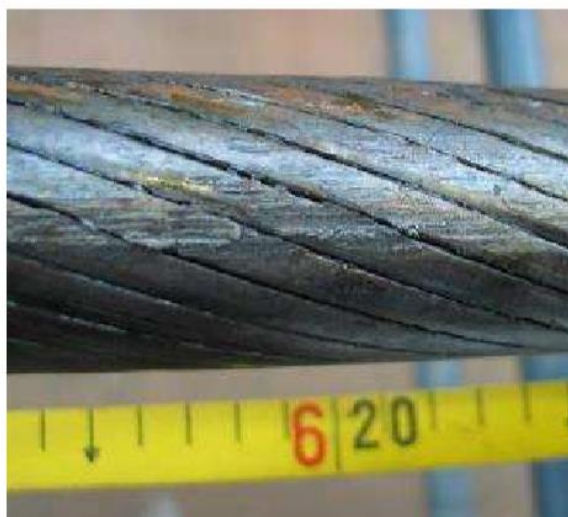
Slika 2.9: Poškodbe na nosilni vrvi [6]
