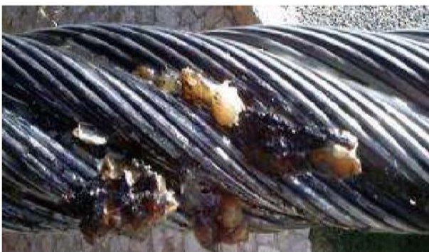
Slika 2.12: Velike poškodbe zaradi strele na pramenasti vrvi
