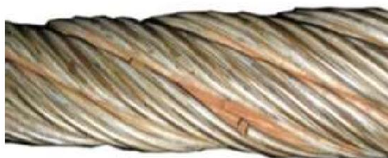
Slika 4.17: Korozija med prameni (z lomi žičk)
