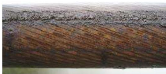
Slika 4.18: Korozija pri popolnoma zaprti vrvi
