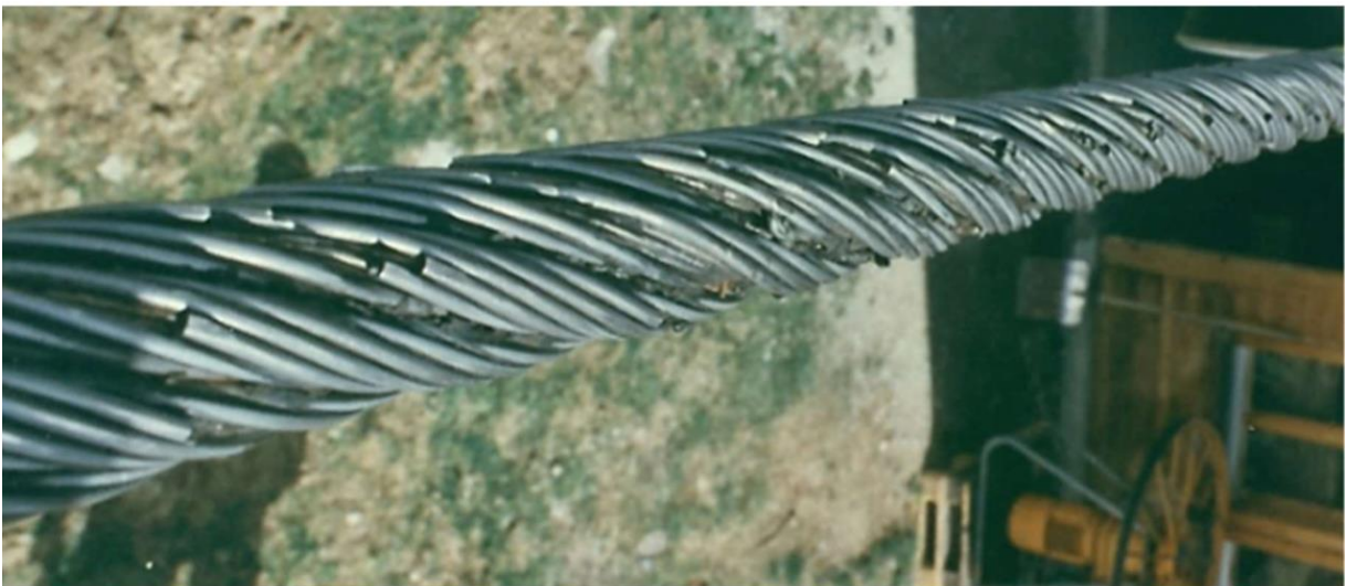
Slika 2.2: Poškodbe zaradi zdrsa prižemne plošče
