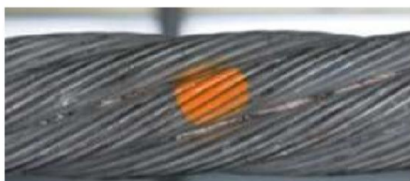
Slika 4.23: Korozija 1 x premer pramena
