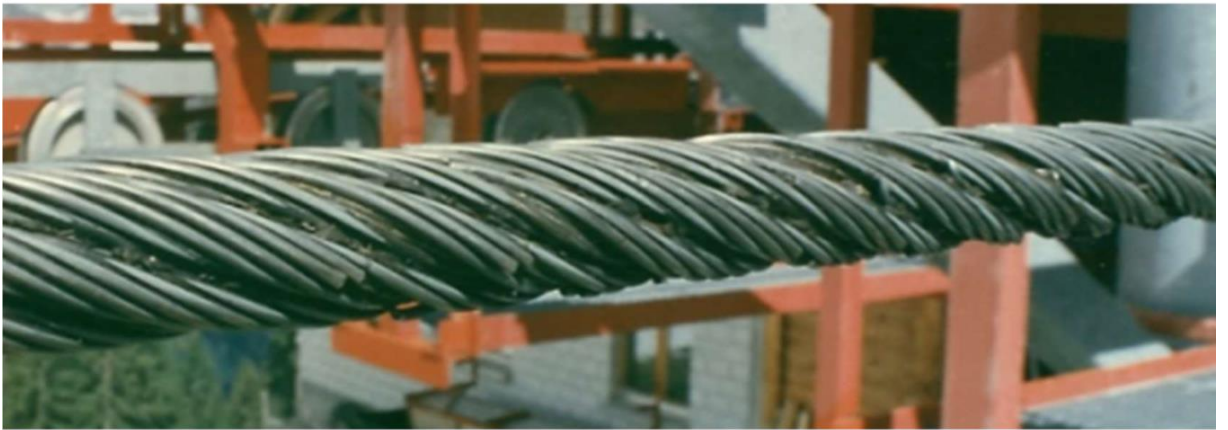
Slika 2.1: Poškodbe zaradi zdrsa prižemne plošče
