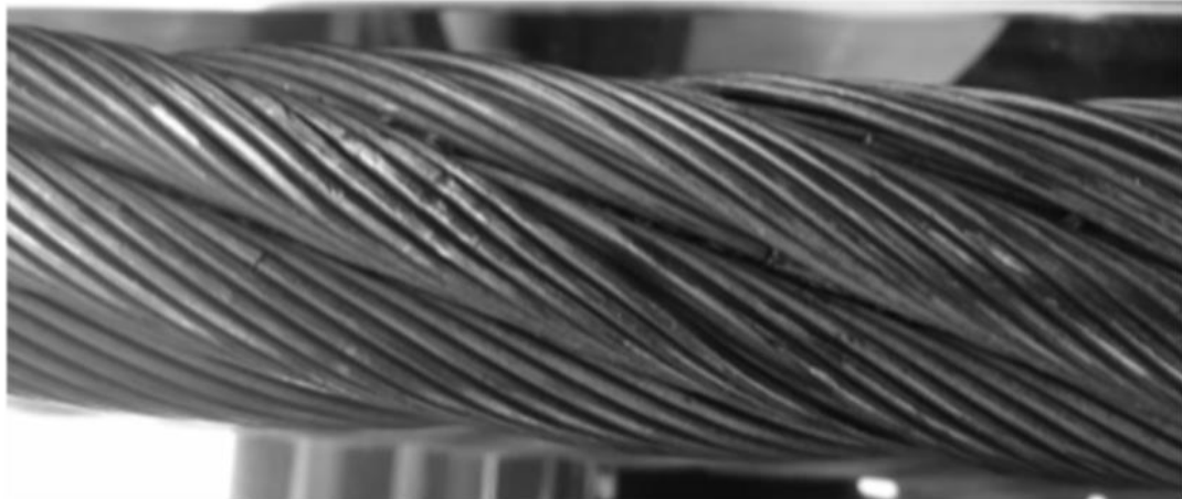
Slika 5.25: Poškodbe, ki so bile najdene med pregledom
