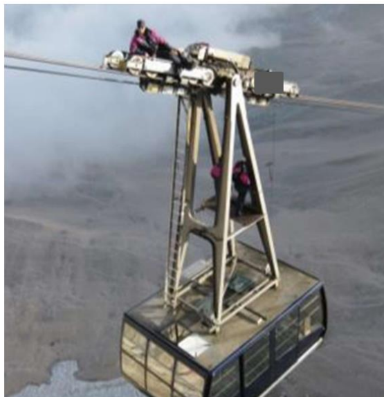
Slika 3.9: Vizualni pregled nosilnih vrvi na platformi in na tekalu
