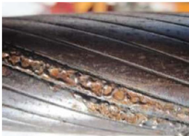
Slika 2.11: Poškodbe zaradi strele na zaprti pramenasti vrvi
